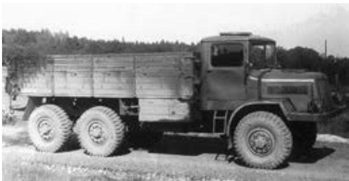
▼ Tatra 130, prototyp pětitunového nákladního terénního automobilu 6×6
