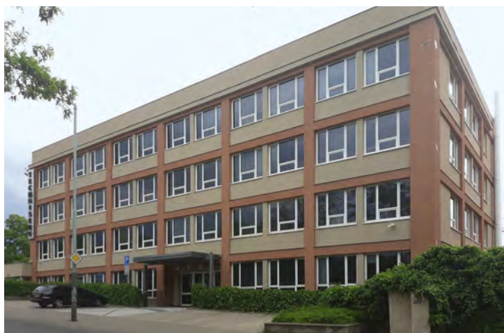
13. Fotografie současného stavu Batovy továrny čp. 949 v Moskevské ulici
