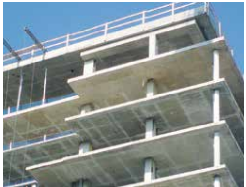
Obr. 1.15 Monolitická železobetonová konstrukce při výstavbě – lokálně podepřená stropní deska s rovným podhledem
