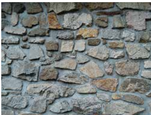
Obr. 1.8 Kamenné zdivo z lomového kamene
