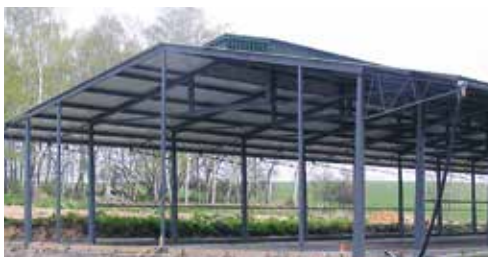
Obr. 1.4 Ocelová konstrukce haly pro zimní ustájení skotu během výstavby
