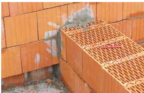
Obr. 1.12 Zdivo z keramických dutinových tvárnic
