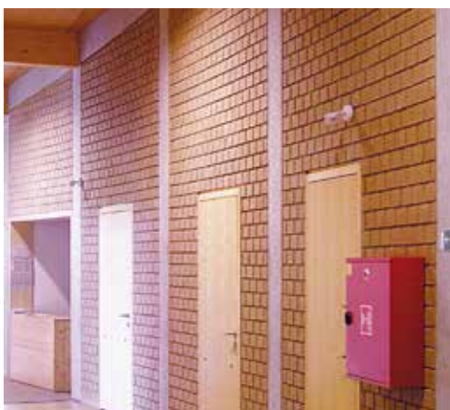
Obr. 1.13 Akumulační vyzdívka z nepálených cihel v Centru ekologických aktivit – Sluňákov
