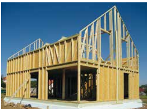
Obr. 1.5 Dřevostavba rodinného domu s lehkým sloupkovým systémem
