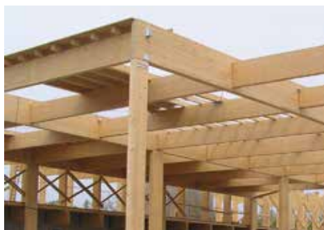
Obr. 1.6 Dřevěná konstrukce haly z lepených lamelových prvků
