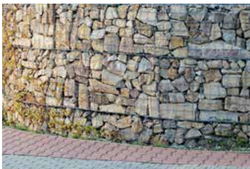
Obr. 1.10 Plot u rodinného domu z gabionů
