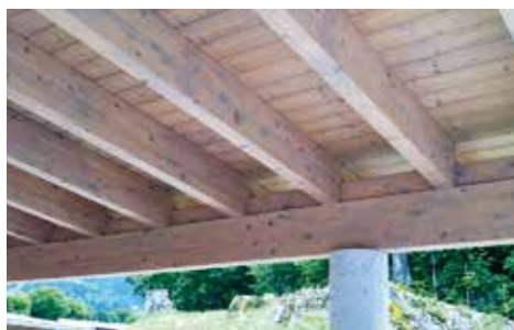
Obr. 1.7 Jednoduchý dřevěný trámový strop
