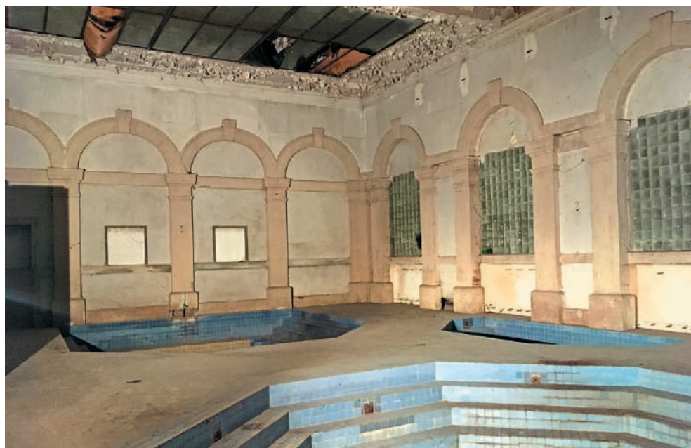
Interiér kúpeľov Grössling v súčasnosti, stav pred rekonštrukciou
