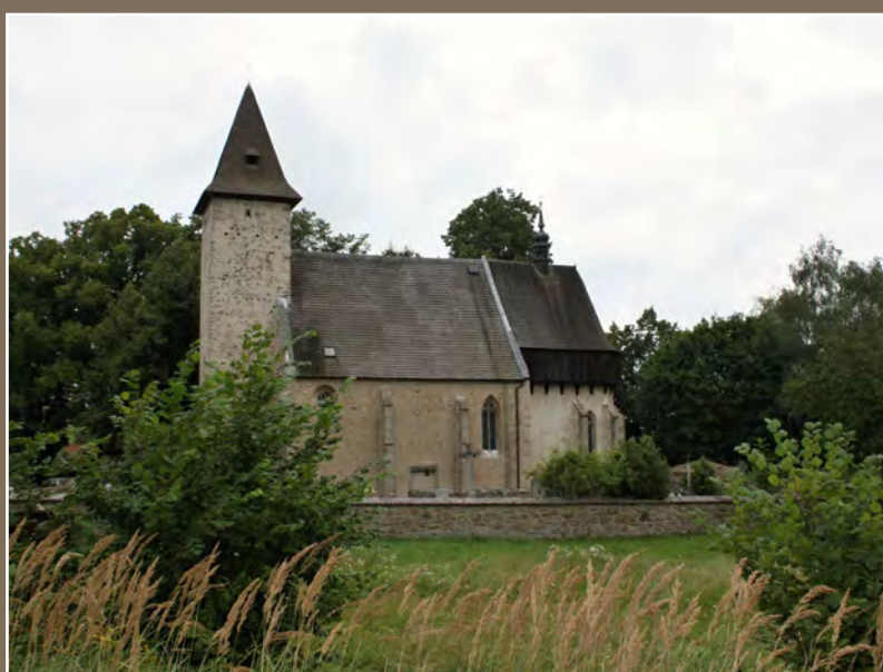
Obr. 4.1.3-1.1 Kostel sv. Línhartu v Liděřovicích
