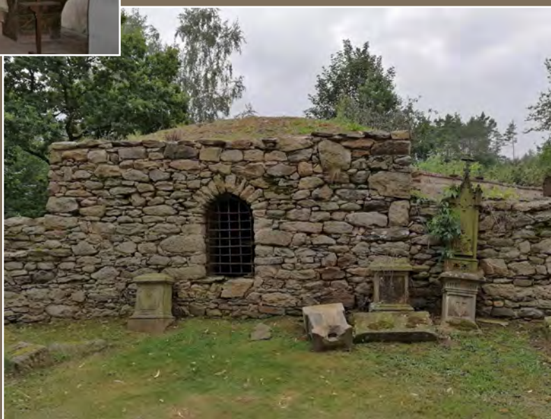
Obr. 4.1.3-2.1 Kostnice v Lidéřovicích
