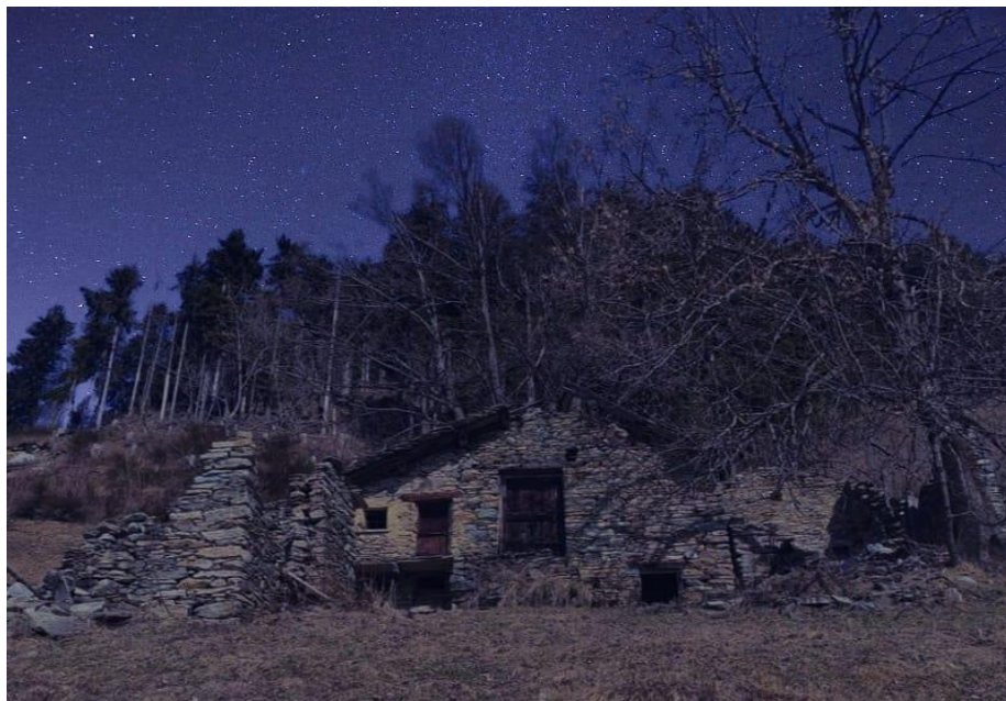
Zbytek hospodářského stavení již neexistujícího mlýna nad Fraciscem
