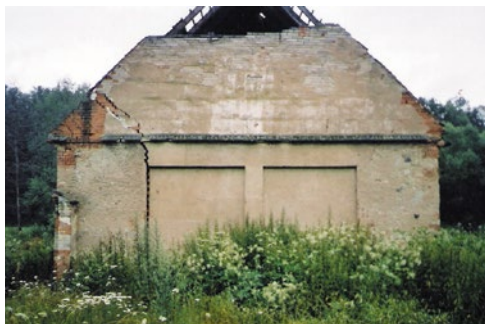
Obrázek 2.13 Trhlina ve zdivu vzniklá v důsledku podmáčení základů vodou z povodňové vlny
