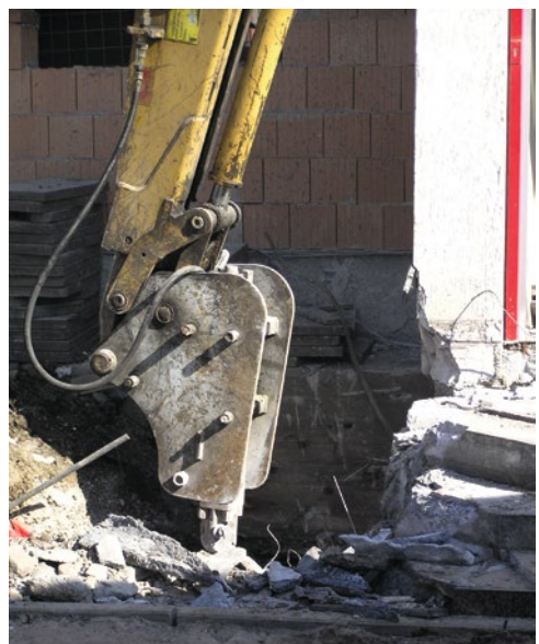
Obrázek 3.3 Bourání pneumatickým kladivem
