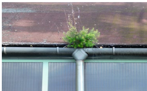
Obrázek 2.16 až 2.19 Příklady poruch způsobených opotřebením materiálu a stárnutím, resp. zanedbanou údržbou
