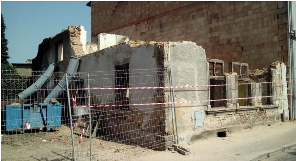
Obrázek 3.1 Ukázka demolice celé budovy
