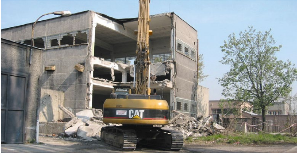
Obrázek 3.2 Ukázka demolice celého objektu s použitím těžké mechanizace
