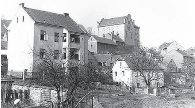
Dům ve Slaném v Havířské ulici čp. 266 (uprostřed vlevo), nahoře uliční fasáda, dole pohled ze zahrady.
