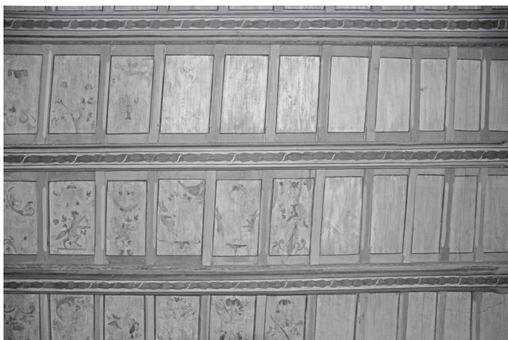
Strop v mezipatře u hlavního schodiště
