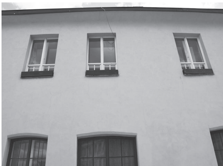
Jednoduchá fasáda domu U Modré hvězdy
