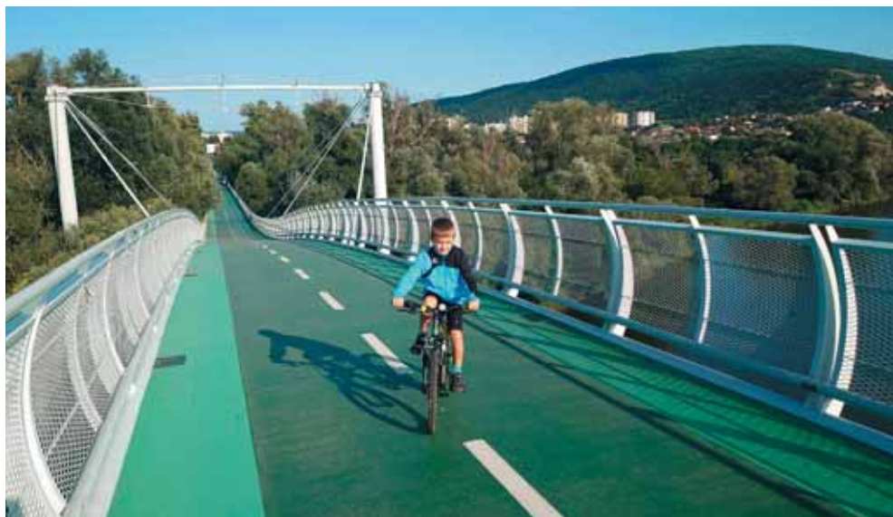
Na Cyklomoste slobody
