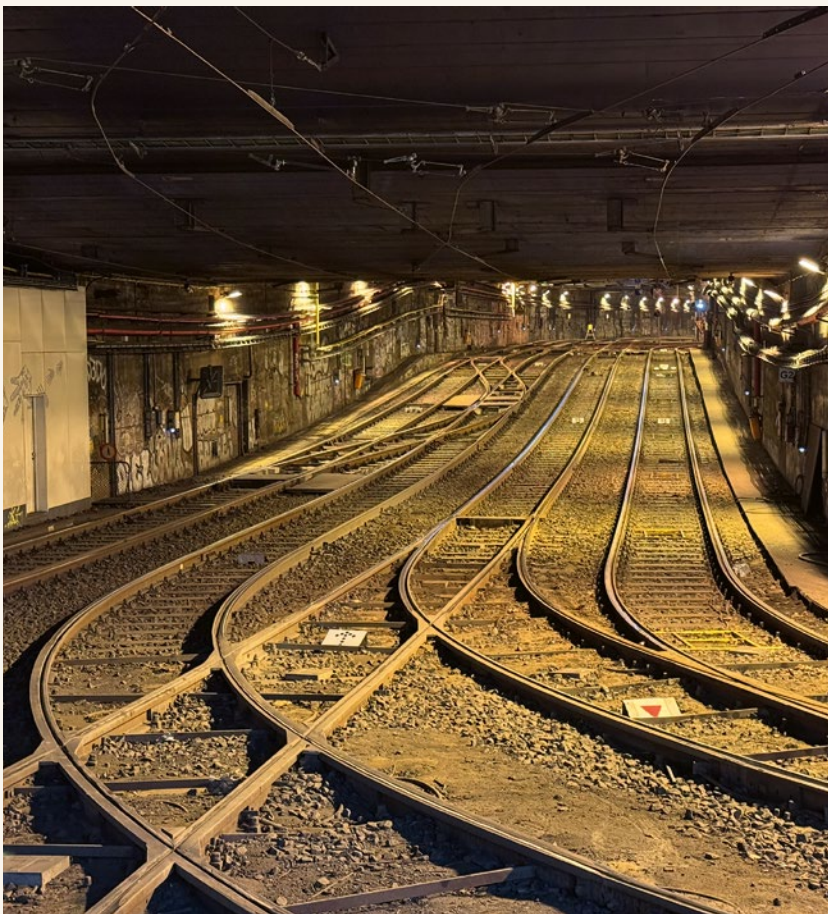
Pohled na čtyřkolejný podzemní úsek prémetro
