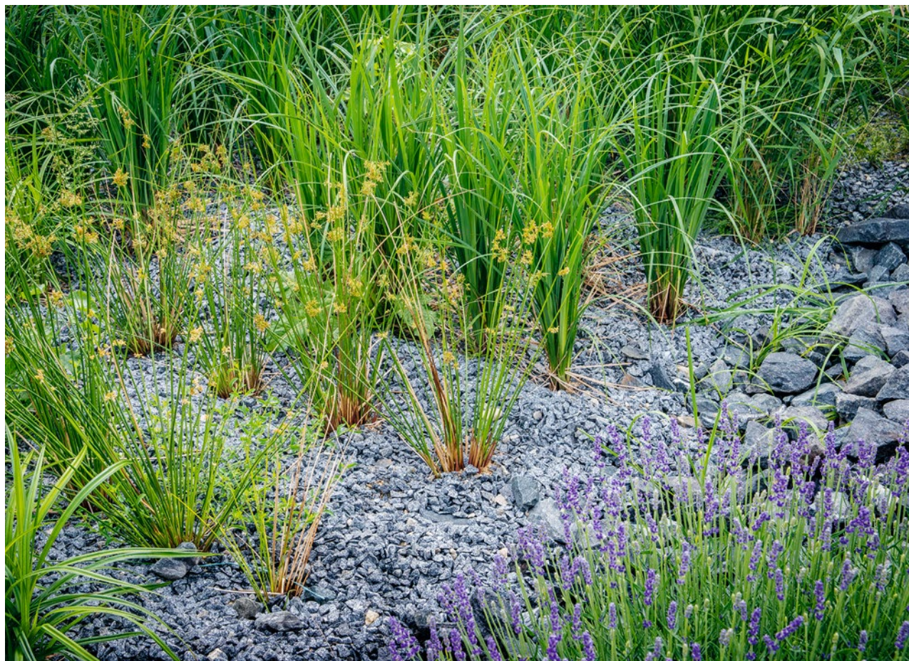
Detail povrchu kořenové čistírny po roce od nasázení.
