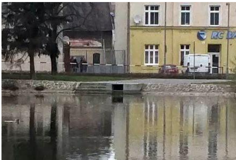
Detail rekonstruované výpusti prostějovského rybníka. Foto Otto Horský, 2021.
