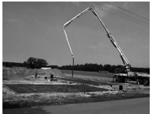
Obrázek 1 Lití betonu na připravenou výztuž základové desky (zdroj: Základy rodinného domu)
