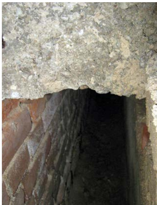
Obrázek 1.9 Vzduchová dutina uvnitř objektu
