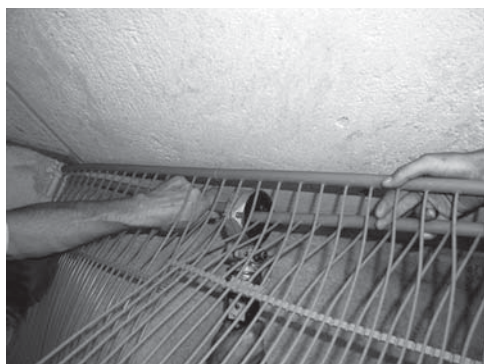
Obr. 3.13 Polyfuzní svařování sběrné a rozvodné trubky kapilárních rohoží
