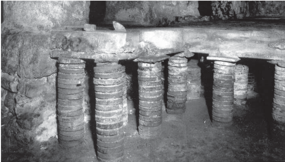
Obr. 3.1 Starořímské Hypokaustum – použití kruhových cihel pro tvorbu spalinových dutin
