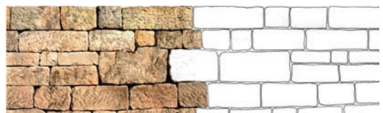
e) nepravidelné vrstvené zdivo
