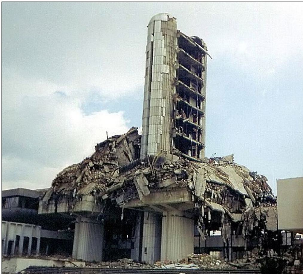
Ruiny budovy deníku Oslobođenje Sarajevo (fotoarchiv autora)
