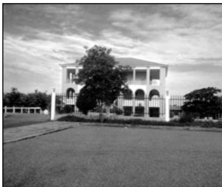
▲ Správní budova na předměstí Caxita
