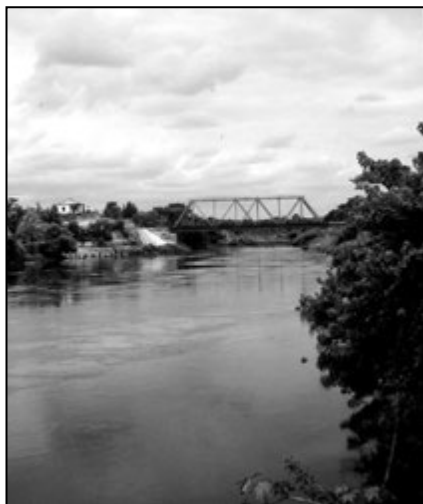
▲ Pohled z pod mostu silničního na most železniční
