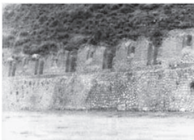
Kallankas - velké pravoúhlé stavební areály
