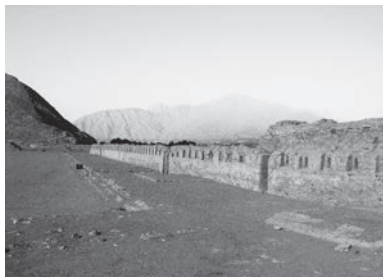
Tambo Colorado vybudované z nepálených cihel adobe
