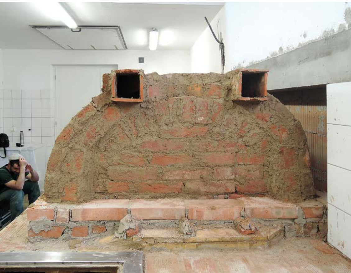
Obr. 1.18 Topné kanály barokní pece stavěné na hliněnou maltu
