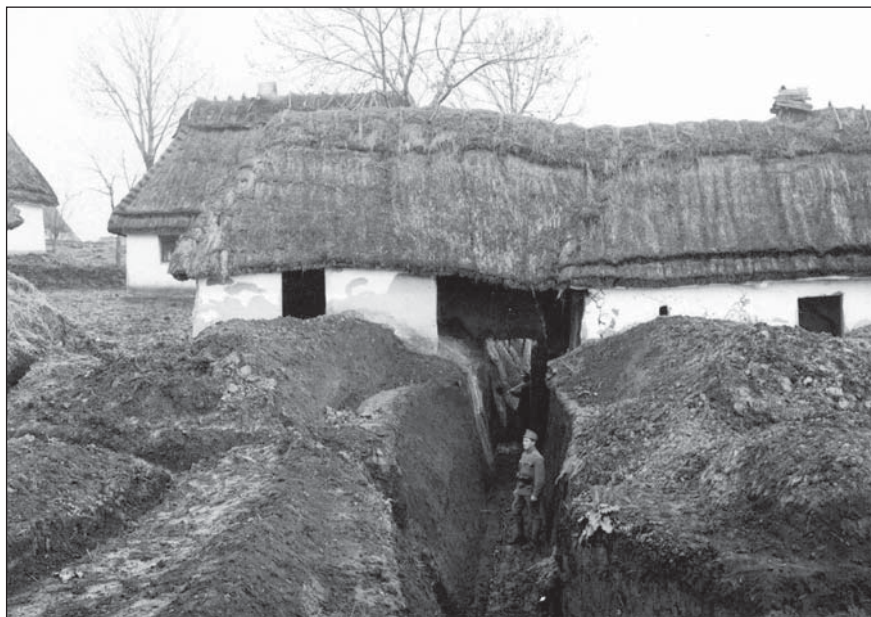
Hlavní zákop měl místy hloubku 2,5 a někde až 3 m.
