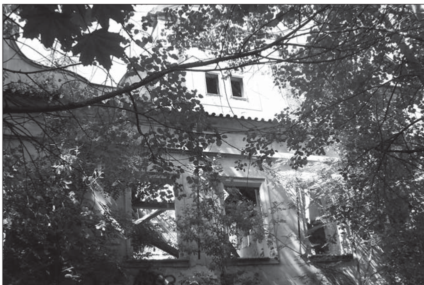
Usedlost Kajetánka v Praze-Břevnově (2008)
