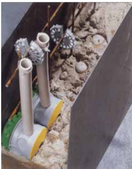
Obr. 9 Krabice a trubky v monolitickém betonu
