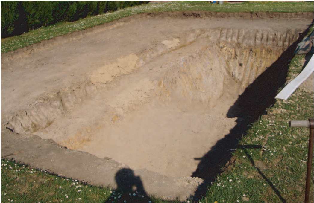
obr. 9 Výkop jednodomového jezírka (hloubka 2,2 m)
