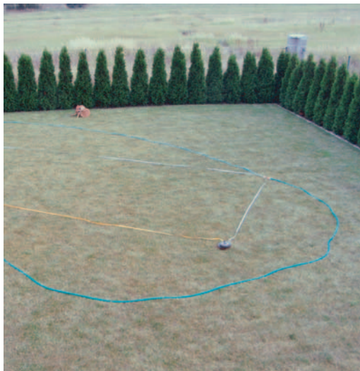
obr. 12 Vyměření tvaru koupacího jezírka
