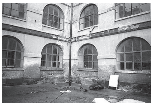
Obr. 1.2 Příklad působení vztlínající zemní vlhkosti
