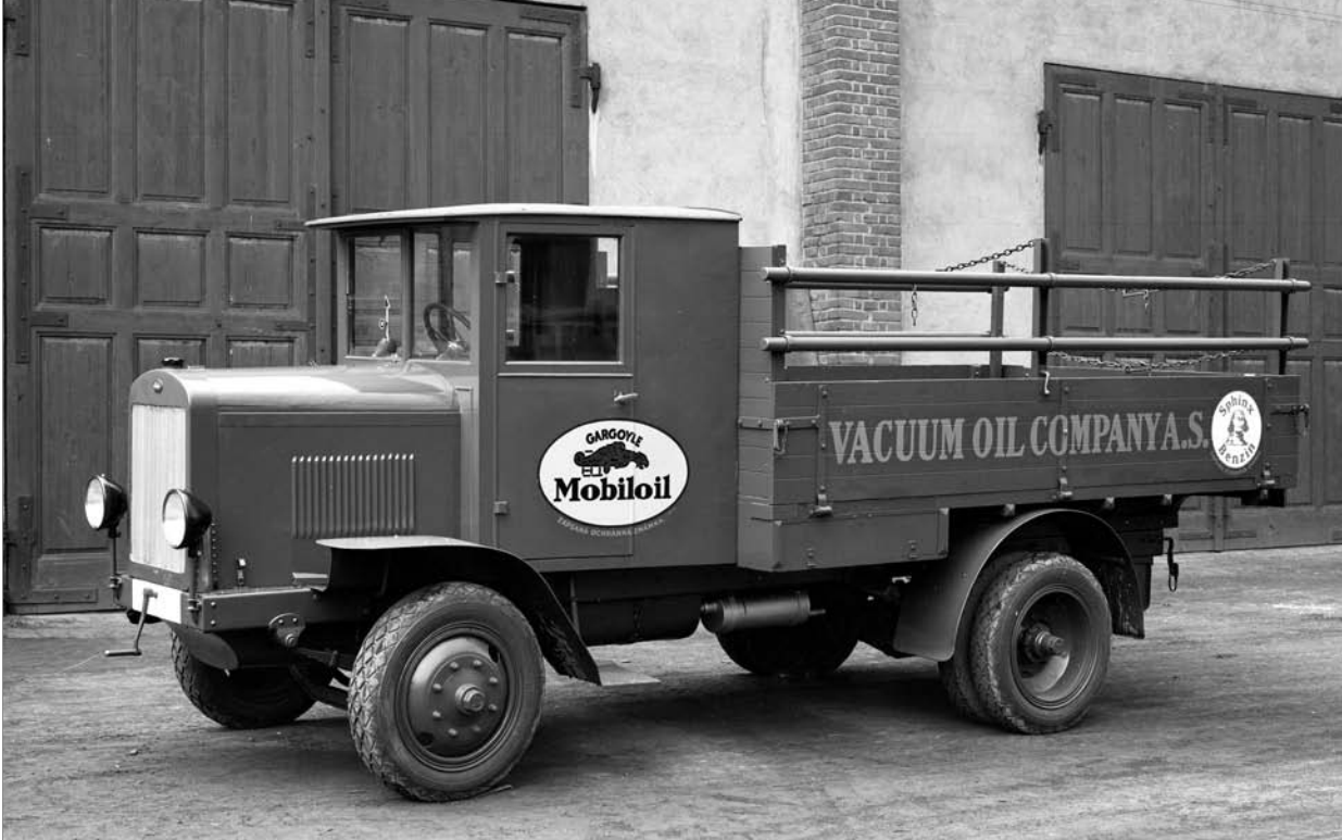
Škoda 505 se začala vyrábět v roce 1923. Řadový čtyřválec o objemu 4713 cm 3 měl výkon 27,9 kW (38 k)
