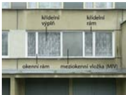
Obr. 3 Použití meziokenních vložek u panelového domu; názvosloví
