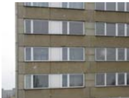
Obr. 3 Použití meziokenních vložek u panelového domu; názvosloví
