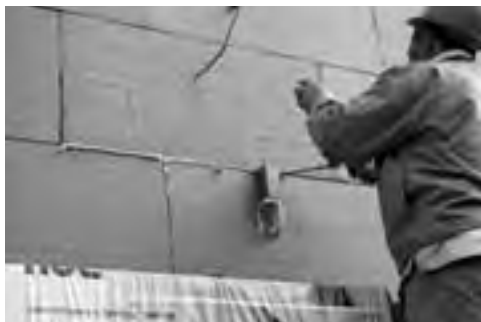
Obr. 20 Nezbytné pečlivé zaplnění všech dutin PUR pěnou
