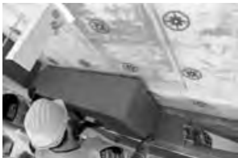
Obr. 19 Laminátová konzola a zateplení 280 mm pěnového polystyrenu s přidavkem grafitu
