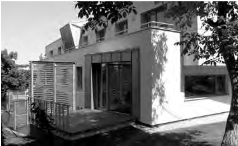
Obr. 18 Dřevěné treláže a terasy se podařilo realizovat z odolného moravského akátu z tuzemských zdrojů, ale v kvalitě tropického dřeva, jako další důraz na snížení ekologické stopy
