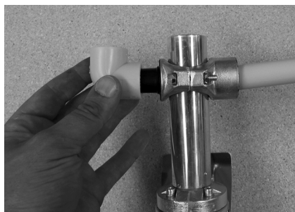
Obr. 16 Ukázka způsobu nahřívání dílů plastového vodovodního potrubí na svářečce
