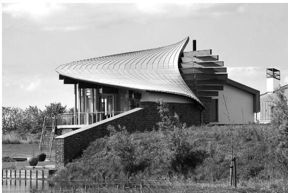
Obr. 2.10 Příklady zakřivených střešních ploch s krytinou Rheinzink (zdroj: vlevo rodinný dům – foto Atelier Simona, vpravo objekt Zijdewind – Rheinzink ČR, s. r. o)
