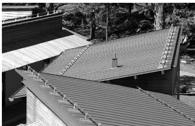
Obr. 2.2 Pultová střecha – foto a schéma (objekt s plechovou krytinou Ekskäret norrtailje, zdroj: Rhein-zink ČR, s. r. o.)
