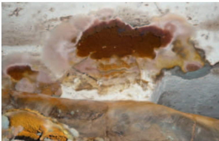
| Obr. 2.5 Dřevomorka domácí
