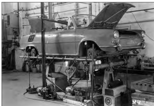
Karoserie Š 991 při tensometrických zkouškách
