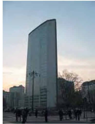
Věž Pirelli od Gio Pontiho a P. L. Nerviho; mezinárodní styl a přesto významná evropská alternativa vůči americkým „krabíčovým“ mrakodrapům: elegantní zeštíhlený šestiboký proudnicový profil – štíhlá stavba ve tvaru křídla letadla. 18. dubna 2002 byl objekt poškozen nárazem lehkého letadla do 26. poschodí
