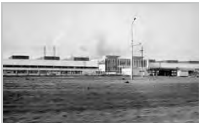
V roce 1970 pokračovala výstavba a zároveň se rozbíhala výroba aut
