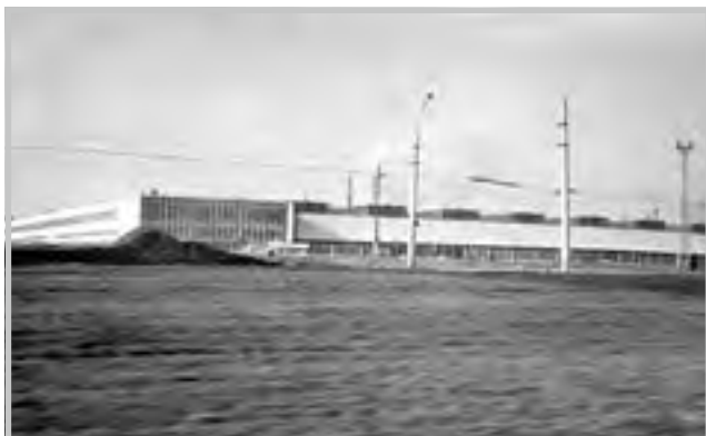
Pohled z okénka „žigulíka“ na ještě nedokončený výrobní komplex
