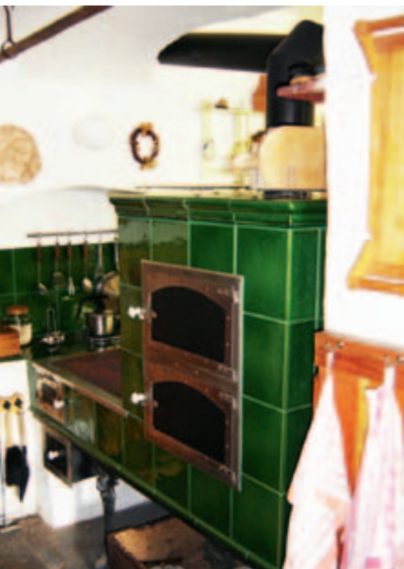
Obr. 2.1 Přestavěný sporák na starém litinovém spodku
