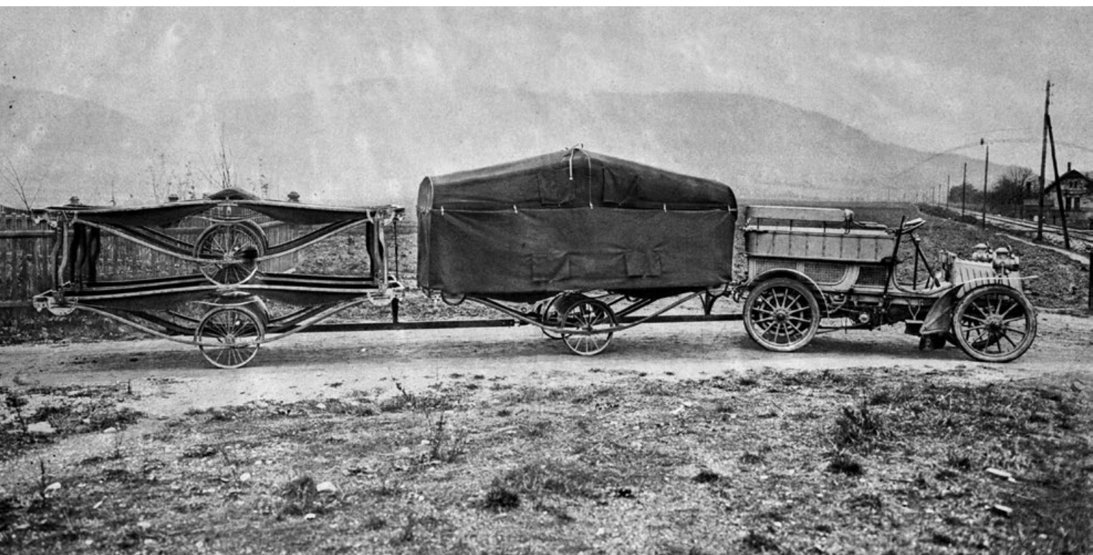
■ Kopřivnický break NW typ B se soupravou sanitních přívěsů Multiplex
