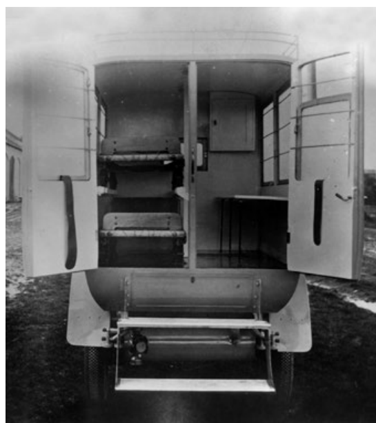
■ Interiér sanitního vozu Laurin a Klement typ M se dvěma lůžky nad sebou
