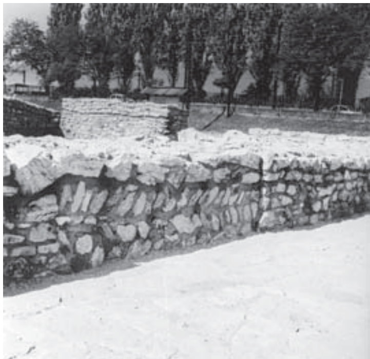
Obr. 2.1 „Opus spicatum“, zbytky římských staveb (Aquincum, Budapešť)
