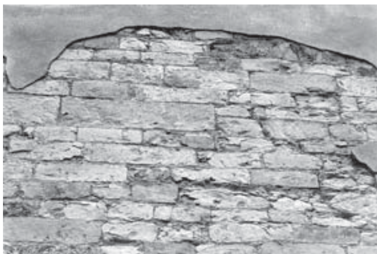
Obr. 3.1 Opukové zdivo s podřezávanými spárami (Strahov – románské zdivo kláštera)
