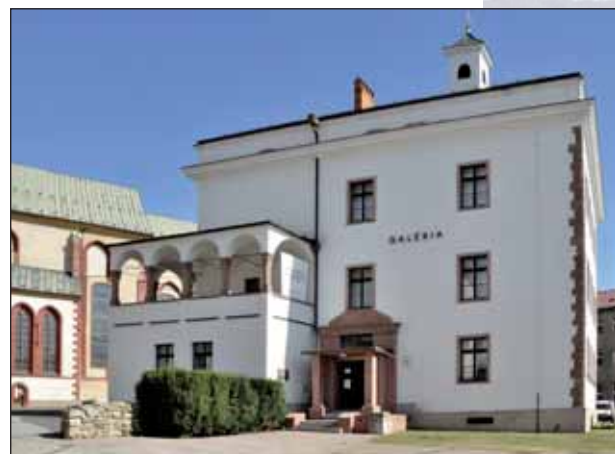
Budova radnice – pretórium je súčasťou hradného areálu.
