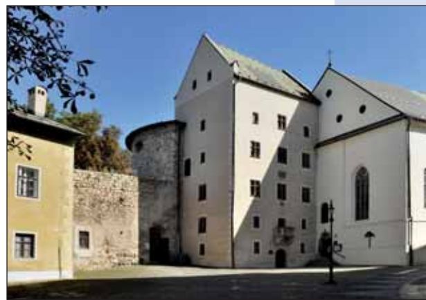
Zľava: okraj fary, časť Baníckej bašty, Matejov dom, vstupná časť do Kostola sv. Kríža
