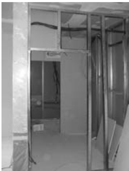
Obr. 5 Konstrukce pro upevnění sádrokartonu
