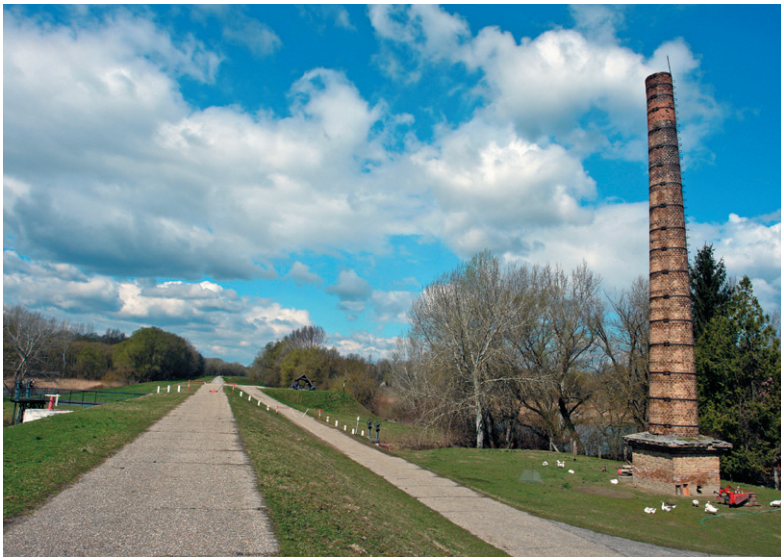
Prečerpávacia stanica pri Čičovskom mŕtvom ramene
