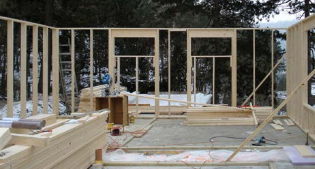
Obr. 1.4 Běžná konstrukce stěn na stavbě
