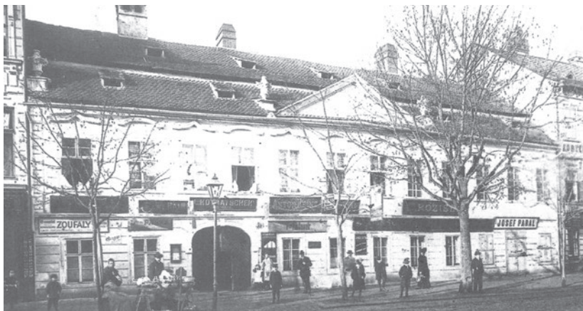
Průčelí bývalé Köffillerovy textilní manufaktury, kterou provozoval od roku 1767 do roku 1792, posléze manufaktura Heinricha Schmala. Podle něj také nedaleká dělnická kolonie v „Červené uličce“ dostala svůj pozdější název „Šmálka“ (foto: AMB)
