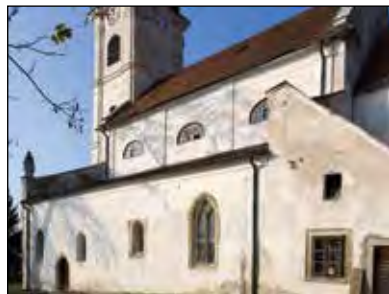
Kostol Povýšenia sv. Kríža v Devíne. Gotické okná južnej kaplnky patria postupným fázam jej výstavby okolo 1330.
