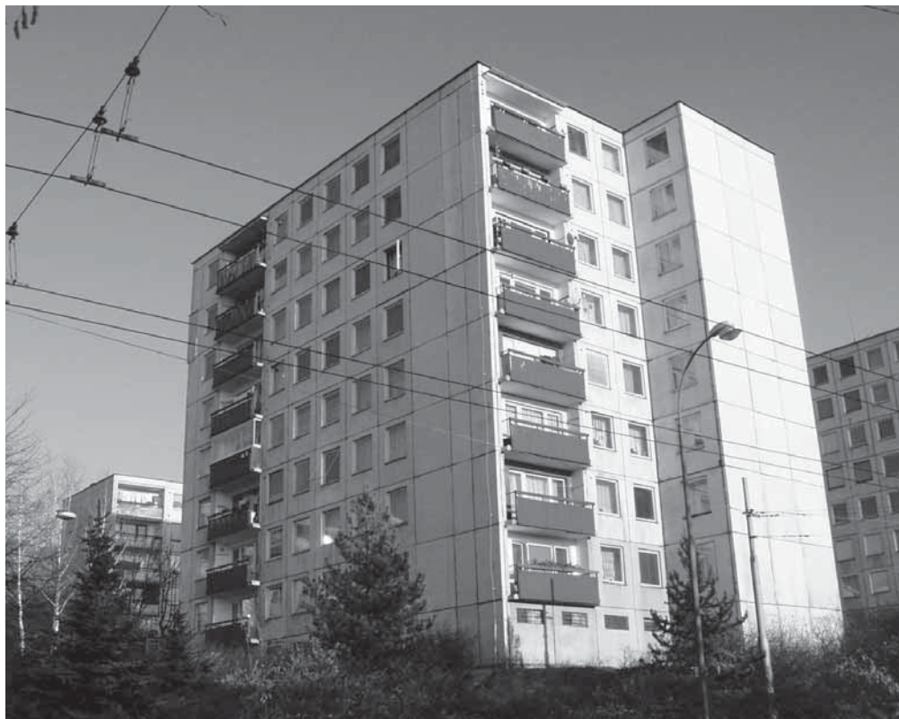
Obr. 4.5 Fasáda bytového domu panelové soustav B 70
