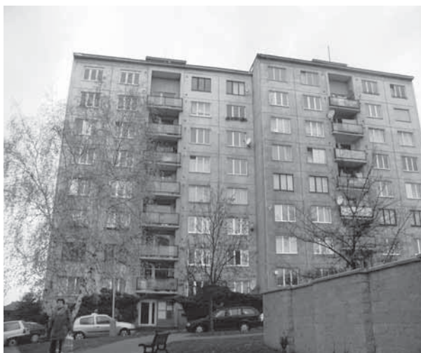
Obr. 4.4 Karlovarská varianta soustavy T 06 B
