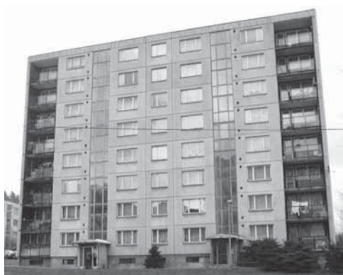
Obr. 4.6 Příklad fasády domu panelové soustavy BA-NKS
