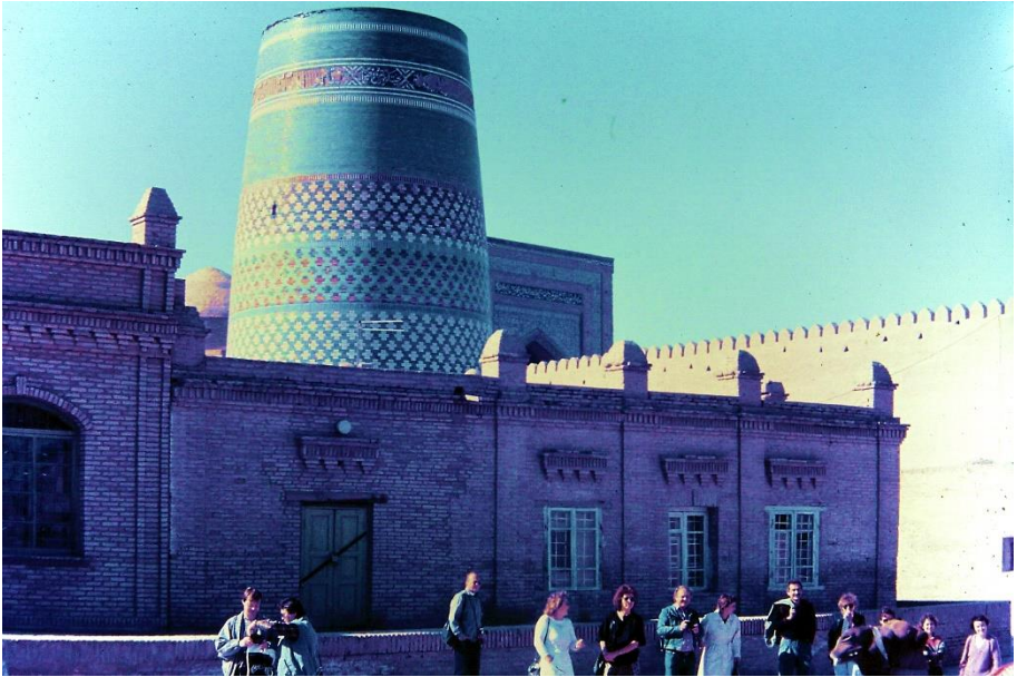
Nedokončený minaret Kalta. Škoda.
