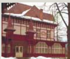
Kollárov dom v Lubochni, kde sa konal ustanovujúci zjazd strany
