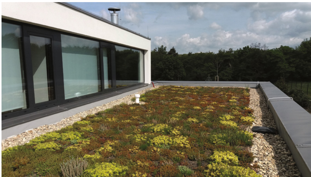
Extenzivní zelená střecha
