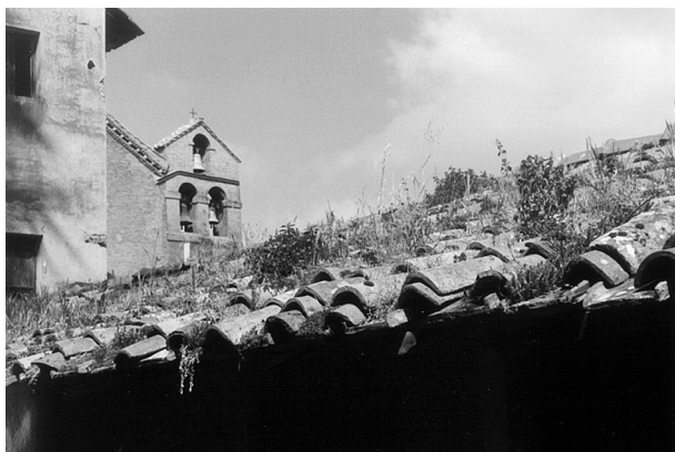
Obr. 2.3 Prejzová krytina (Abbazia delle Tre Fontane, Řím)
