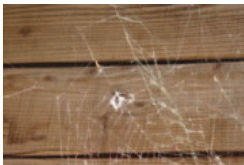
Obr. 2.13 Pavučina na dřevěné fasádě. Vysoké teploty povrchu a nízká tepelná vodivost dřeva poskytují dobré podmínky usídlení hmyzu.
