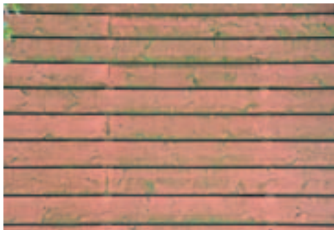
Obr. 2.10 Tvorba řas na severní fasádě. Je nápadné, že se řasy vyskytují nejvíce na spodním kraji prken, protože tam je největší kumulace nečistot. Čím více nečistot se zachytí, tím více řas se nahromadí. Prkna otevřené překryvané fasády mají naspodu ostré okraje, tam se vymývá barevný nátěr – prkno je v těchto místech nejdéle vlhké.
