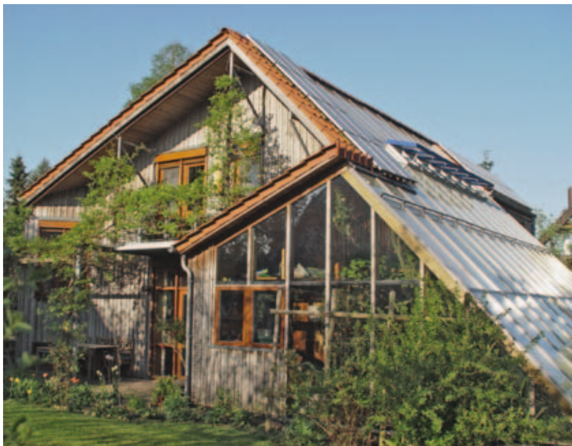
Obr. 1.11 Ekologický dům ze začátku 80. let. Velká zimní zahrada a neošetřená fasáda z modřínového dřeva. I když v té době došlo k mnoha chybám a omylům v realizaci, jsou zkušenosti a poznatky i pro současné stavebnictví nepostradatelné. Tím, že se stavebníci identifikovali se svými domy, vytvořili si k nim emocionální vztahy, které jsou přes objektivní nedostatky mnohem intenzivnější než u konvenčních budov.
