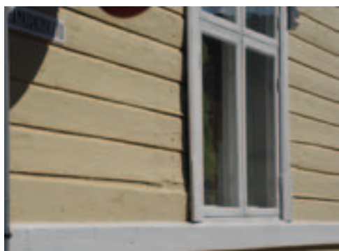
Obr. 1.2 a 1.3 Nejstarší finské fasády ze dřeva z oblasti Rauma z 18. století. Porušení fasády, vyvolané povětrnostními vlivy, se pravidelně opravovalo. Nátěry prováděné několikrát do roka držely fasádu pohromadě lépe než původní spojovací prostředky.
