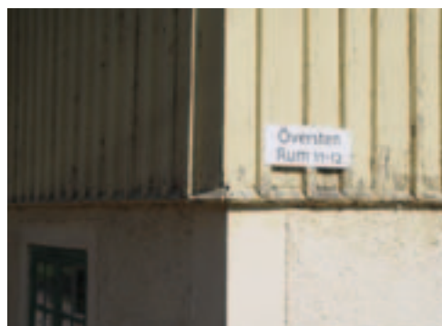
Obr. 1.6 Hospodářské stavení ve středním Švédsku. Spodní část přechodu fasády ke zdi – k omítnutému zdivu se připojila okapová hrana. Je to patření účinné, které však netrvá věčně.
