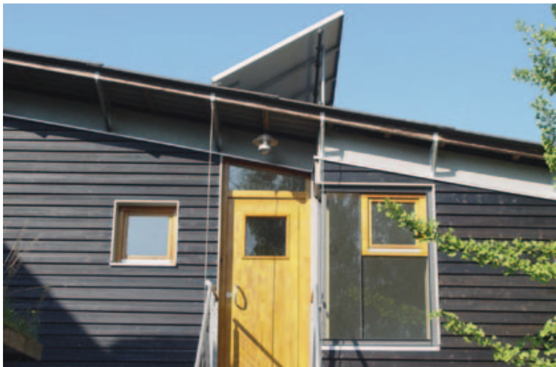
Obr. 2.9 Rodinný dům autora má dřevěnou fasádu natřenou černým lazurovacím lakem a je názorným příkladem typického konfliktu v průběhu výstavby: na jedné straně elegantní barva, na druhé straně vyšší tepelná expozice a kratší intervaly údržby. Pro barvu se můžeme zodpovědněji rozhodnout, když si uvědomíme tyto důsledky.
